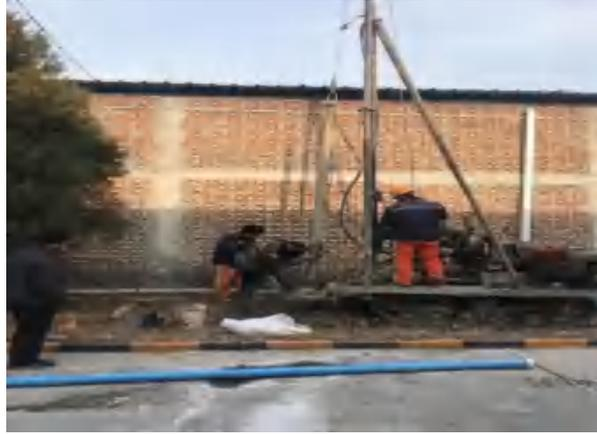
图 9-3 地下水监测井钻孔
